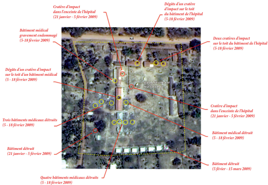
Image 7 : Évaluation par imagerie satellite des dommages subis par l'hôpital de Vallipunam au Sri Lanka (UNITAR/UNOSAT).
